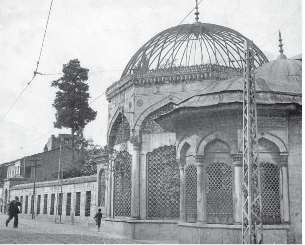
Gülnuş Emetullah Valide Sultan Türbesi ve Sebili Salt Araştırma, Ülgen Ailesi Arşivi.
