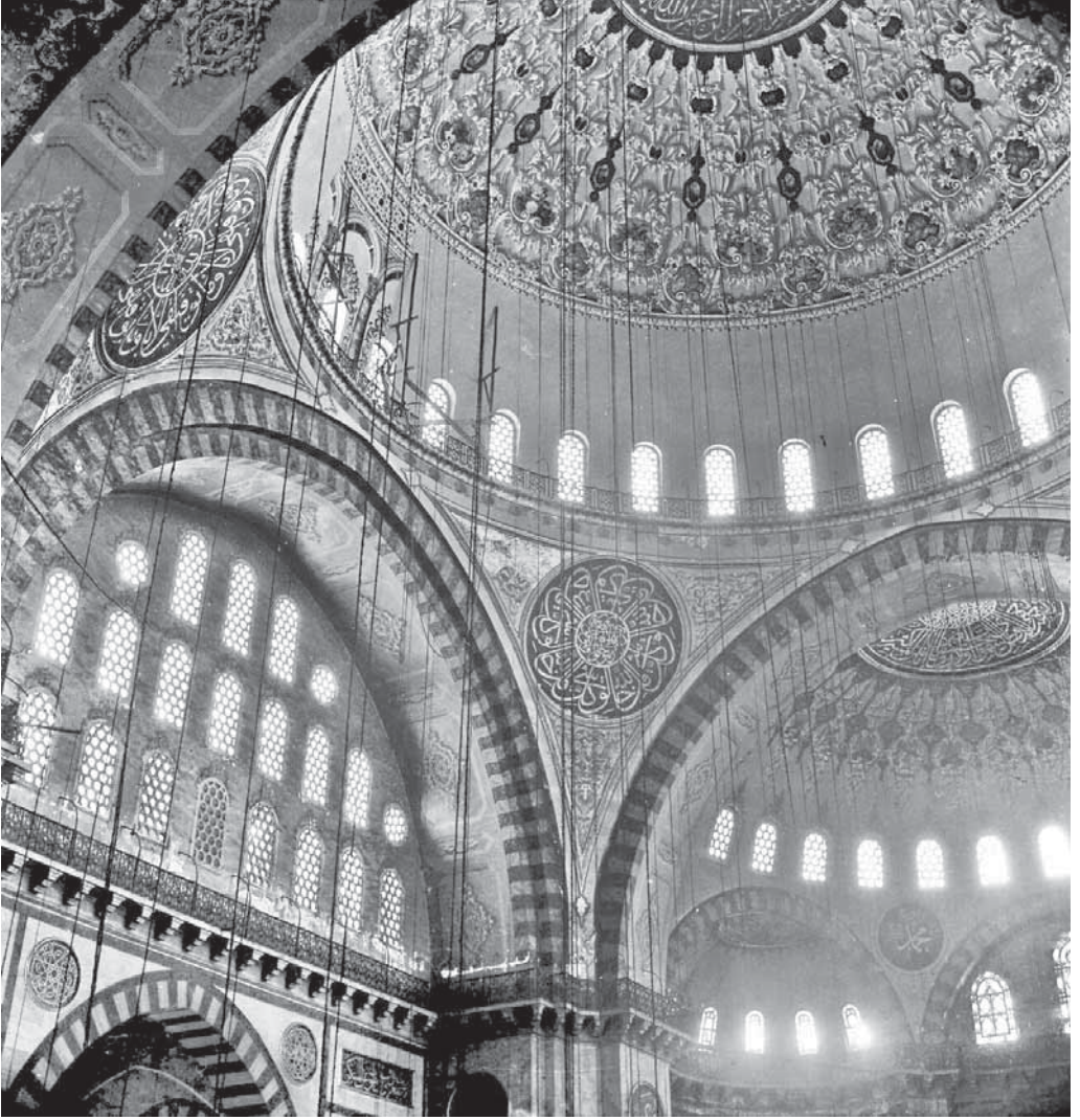
Süleymaniye Camii'nin İç Mekanı Salt Araştırma, Ülgen Ailesi Arşivi. Süleymaniye Camii'nin İç Mekânı, Kubbe ve Pandantifler.
